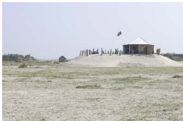
École GK de Baladuda sur le socle de terre destiné à la mettre hors d'atteinte des crues
