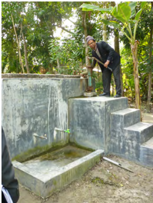
Filtre à sable terminé avec la pompe en haut à droite servant à amener l'eau de la mare aux cuves du filtre.
