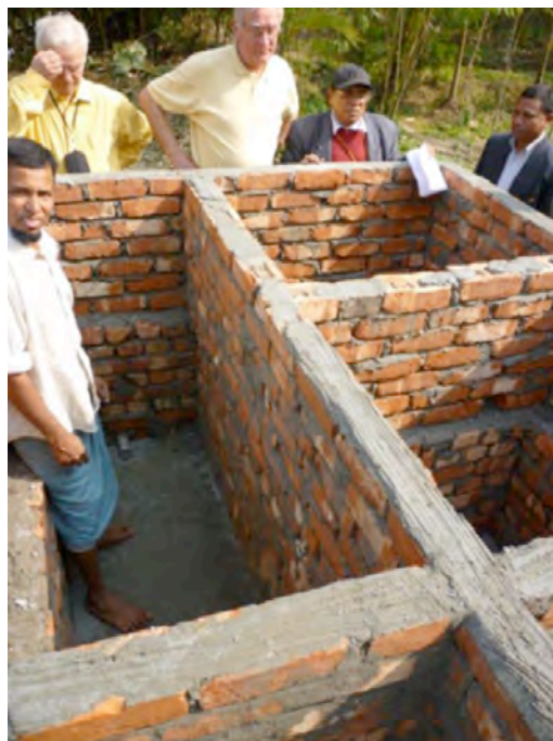
filtre à sable en construction (au fond Jacques Lejeune, Marc Chambolle et l'Ingénieur Mitra)
