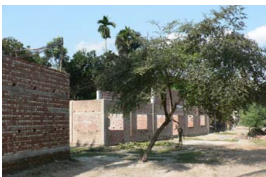
Hôpital de Gaibandha en cours de construction (photo Lejeune)
