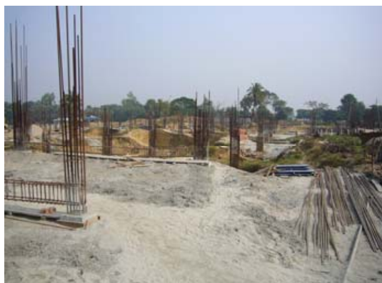
La future université en construction à Savar (photo Lejeune)
