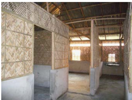
Centre de santé intégré de Janghail construit en matériaux locaux (photo Lejeune)
