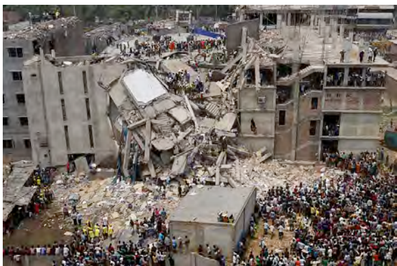
le Rana Plaza après l'effondrement des étages supérieurs et du corps central du bâtiment © Rijans007-Wikipedia
