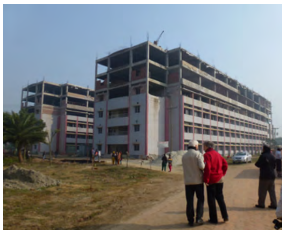
le bâtiment de l'université GB en cours de triplement de la capacité d'accueil
