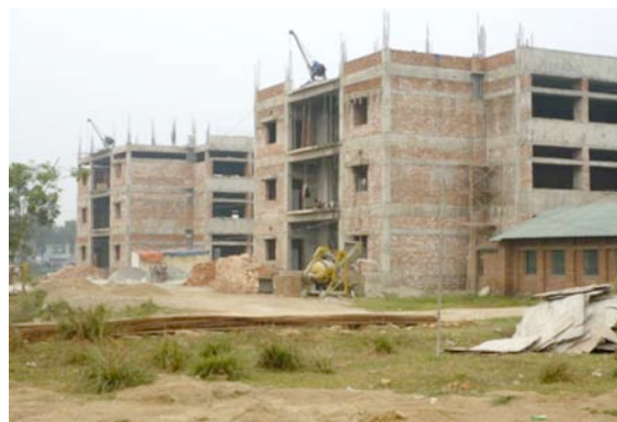
Bâtiments en construction pour l'extension de l'Université
