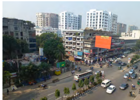
vieux et nouveaux immeubles à Danmondhi, quartier de Dhaka (à g. maison en démolition)
